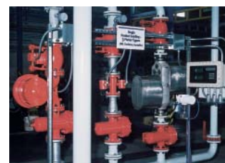
Налив одного продукта – 3 типа измерителя (Камерный (объемный), турбинный и Кориолисов)
