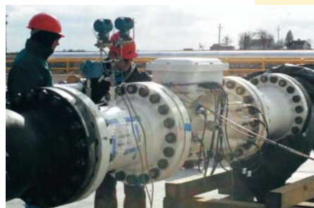
Ультразвуковой газовый расходомер серии MPU, установленный в линии
