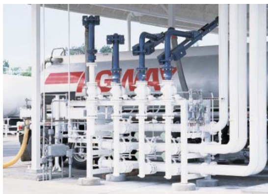
Турбинные измерители серии Guardsman L фирмы СМИТ... Измеритель, которому отдается предпочтение на наливных эстакадах
