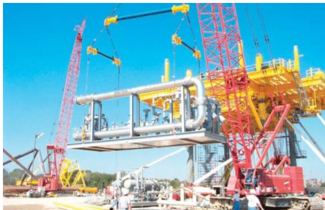
Этот узел учета для El Paso Production в Мексиканском заливе, ST 204-B, 30,000 BPD LACT включает в себя два 8-дюймовых расходомера объемного типа компании Smith.
