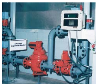
Смеситель для последовательного смешения двух продуктов
