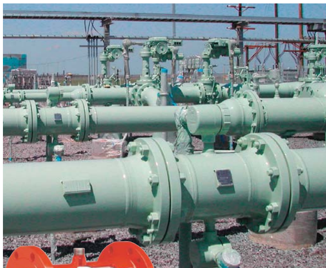
6-дюймовые турбинные измерители серии MV, расположенные на трубопроводном терминале.
