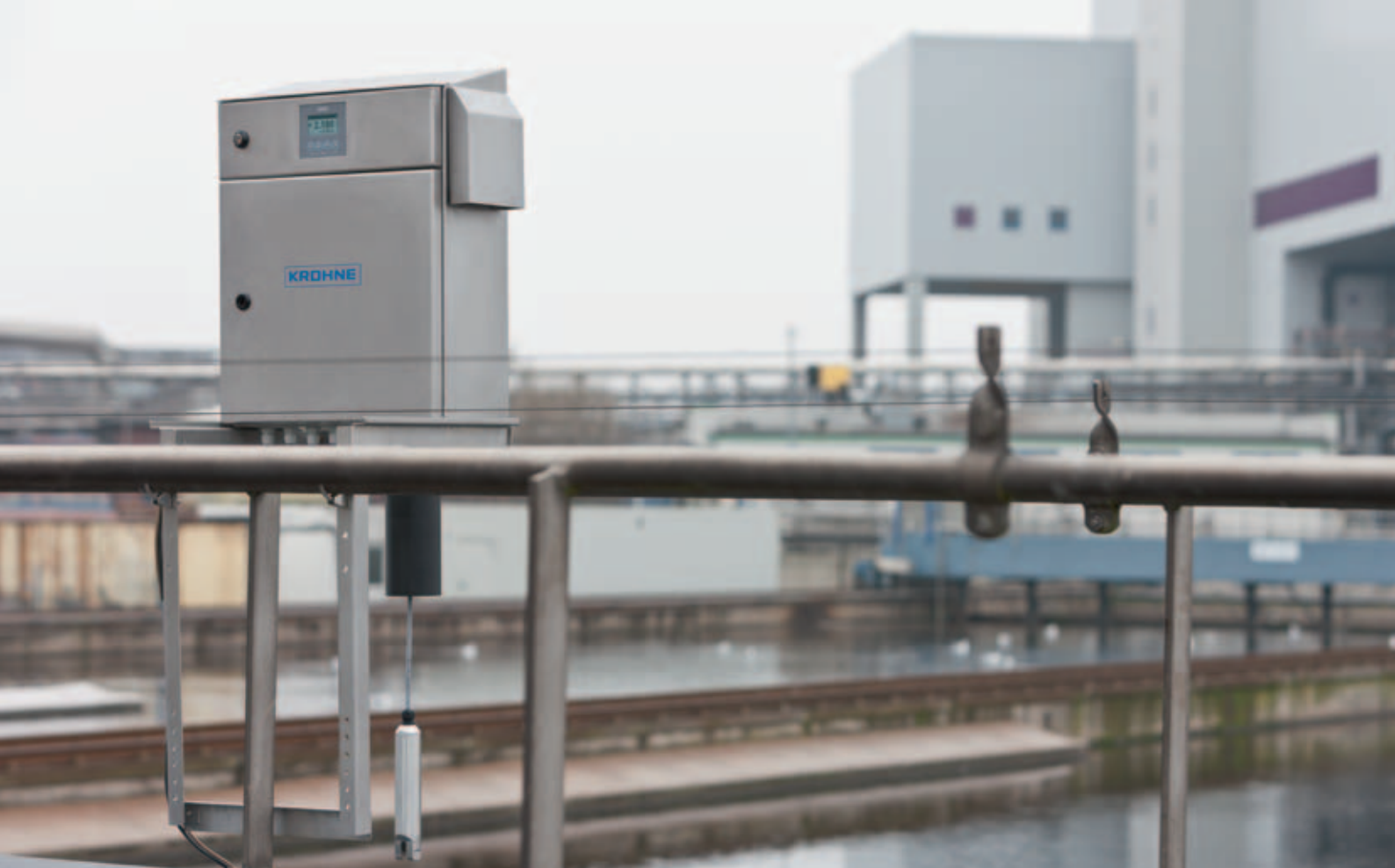
Измерение взвешенного слоя осадка во вторичном осветлителе очистной установки сточных вод, Крефельд, Германия
