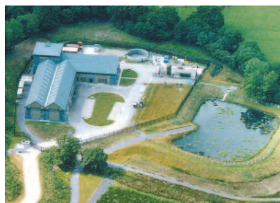
Пример труднодоступной насосной станции
