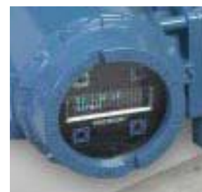
Полевой электронный блок анализатора Oxymitter 4000 монтируется прямо на кислородном зонде в стандартном корпусе NEMA 4X, IP 66.
