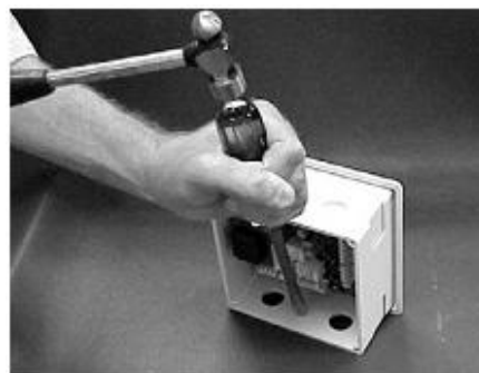
РИСУНОК 4-1. Выбивание окон-врезок
