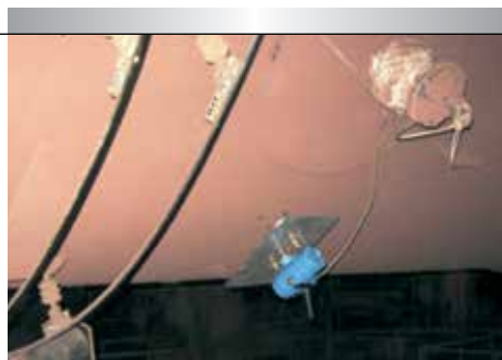
Беспроводной преобразователь температуры Rosemount 648 на стенке печи
