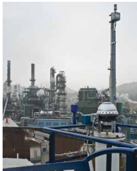
Уровнемер TankRadar Rex установлен с преобразователем сигнала в беспроводной Smart Wireless THUM
