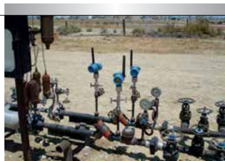
Датчики давления 3051S WirelessHART на скважинах двойного паронагнетания
