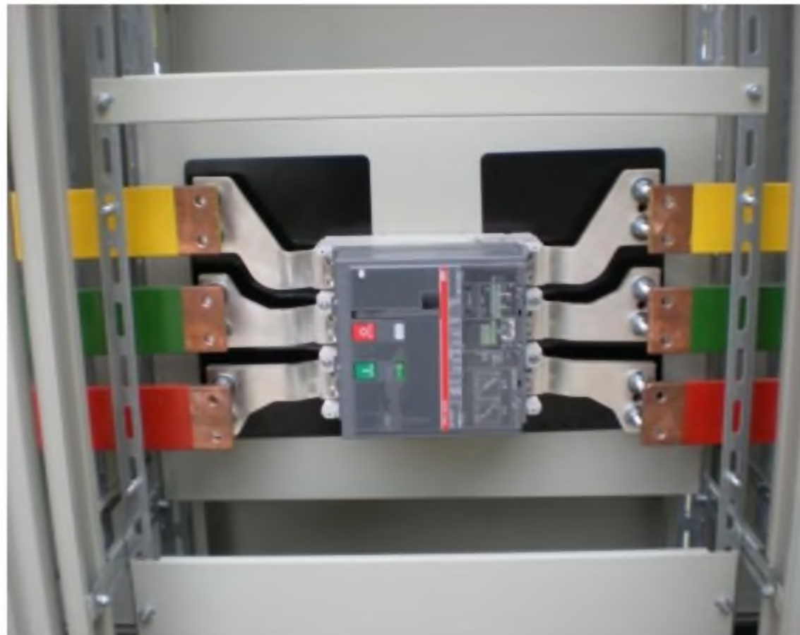
Организация подключения автомата к шинам (с двух сторон)
